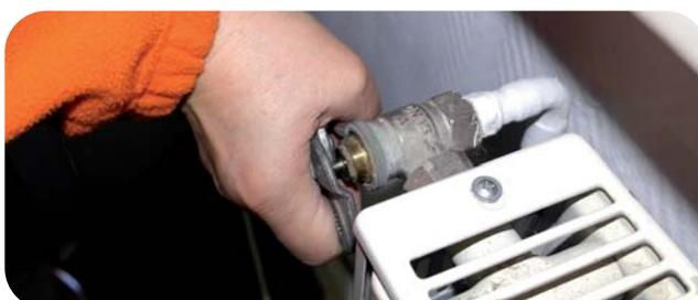
**4. Den Thermostatkopf auf die höchste Stufe stellen und wieder aufschrauben**
