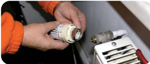
**2. Ventilstift vorsichtig mit einer Zange aus dem Ventil ziehen und mit etwas Ölspray (z.B. mit WD-40 Classic) einsprühen**
