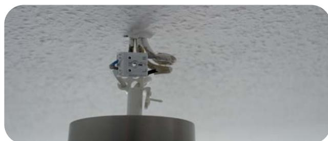
**5.** Mit einer Lüsterklemme stellen Sie die Verbindung zwischen den Kabeln her. Dazu drehen Sie die kleine Schraube der Klemme auf, stecken das jeweilige gleichfarbige in die gegenüberliegenden Löcher und drehen die Schraube wieder fest. In manchen Lampen fehlt das Grün-Gelbe Kabel, dann kann das entsprechende Gegenstück unverbunden bleiben.
