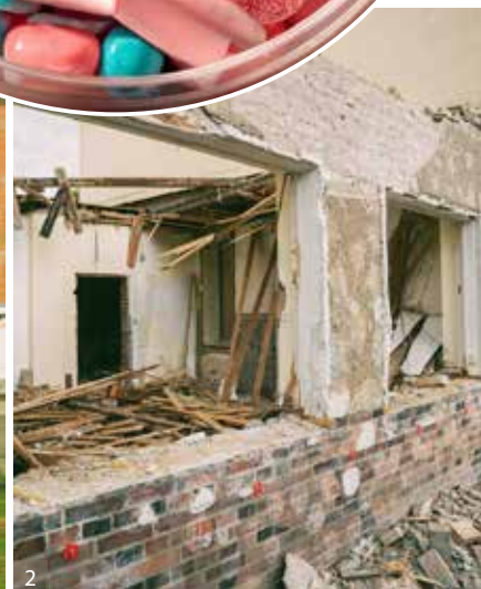
1 Das marode Geschäftshaus in der Grabowstraße, ehemals als DDR-Intershop bekannt, wurde Ende Juni zurückgebaut | 2 Das Gebäude wurde zunächst entkernt, dann folgte der Rückbau der Außenwände
