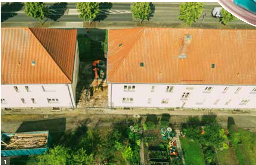
1 Das marode Geschäftshaus in der Grabowstraße, ehemals als DDR-Intershop bekannt, wurde Ende Juni zurückgebaut | 2 Das Gebäude wurde zunächst entkernt, dann folgte der Rückbau der Außenwände
